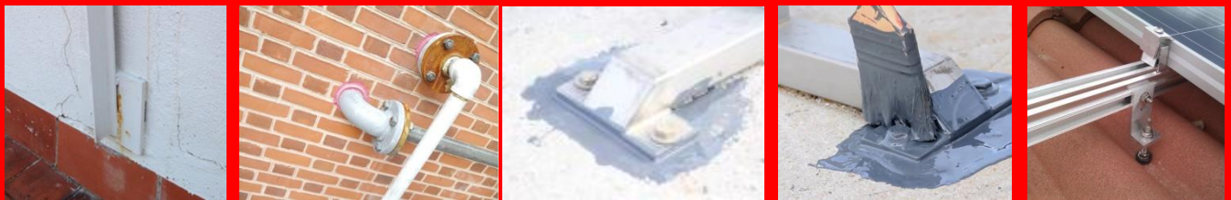
Perforaciones y puntos de anclaje de otros elementos metálicos
