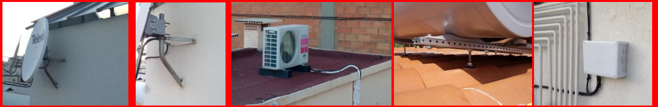
Anclaje de parabólicas, cajas de luz o sistemas de aire acondicionado
